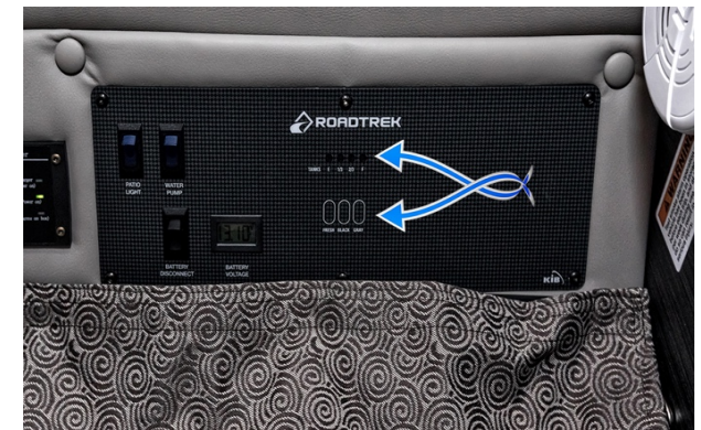
Figure 55.1 Indicateurs de niveau pour les réservoirs
