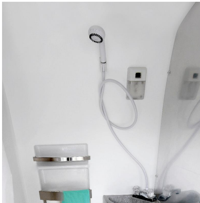
23.1 Raccordement de la douche et pompeau
