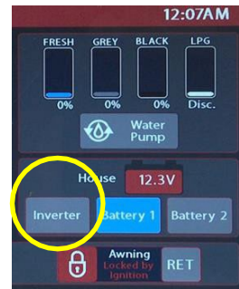
Interrupteur de l'onduleur 46.2
