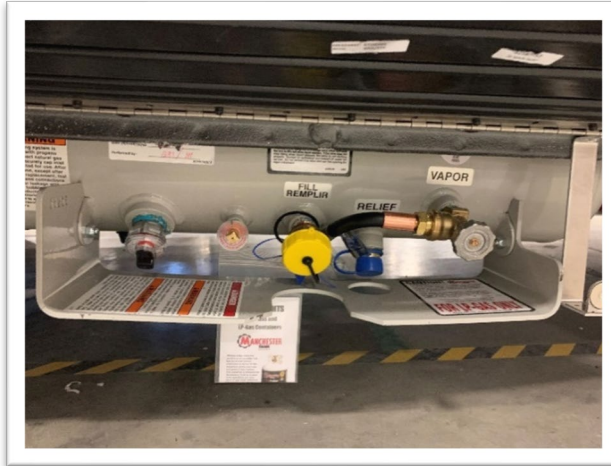
Réservoir de propane
