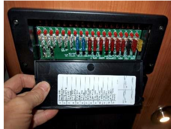
12 volt DC fuse box
