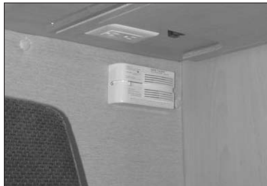
Photo F-P2: Détecteur de fuite de monoxyde de carbone
