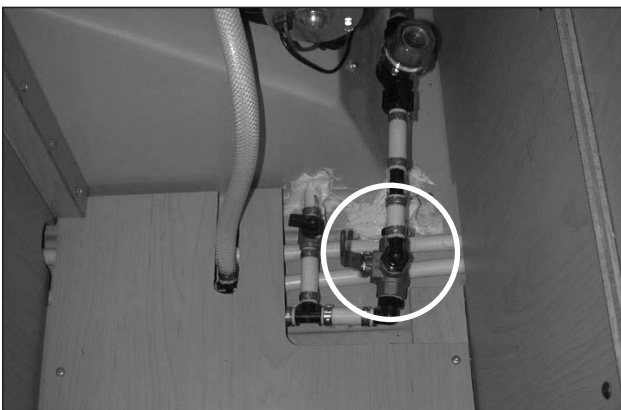
Photo G-P1: Robinet sélecteur à la position du réservoir d'eau potable intérieur
