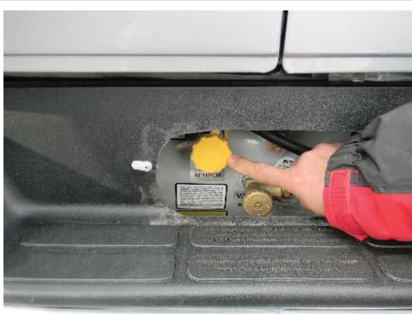
Propane fill valve
